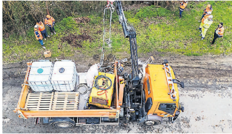
Des travaux ont été réalisés sur les axes routiers autour de Saint-Gaudens. / CD31
