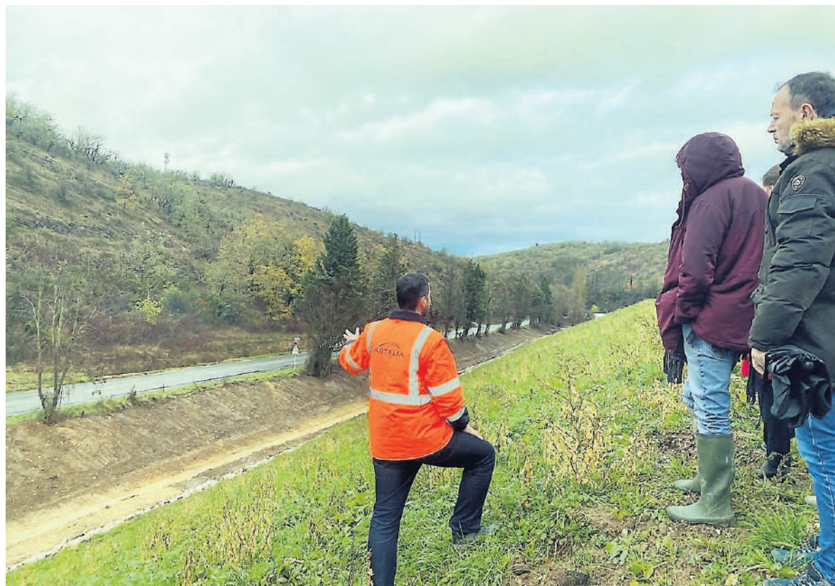
Un lit naturel va être creusé directement dans le calcaire pour laisser couler le ruisseau. / DDM – Laurine Méaulle
